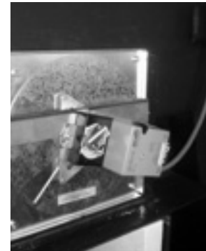
Sekundärluftklappe montiert.
